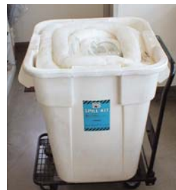
吸収材の設置
